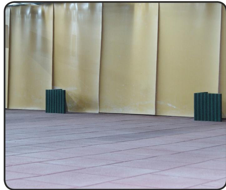
**1** Detrás de las láminas, sobre la pared, se colocan planchas de acero laminado balístico 500 Brinell de 8 mm. para proteger la pared de los daños ocasionados en caso de falta de mantenimiento.
